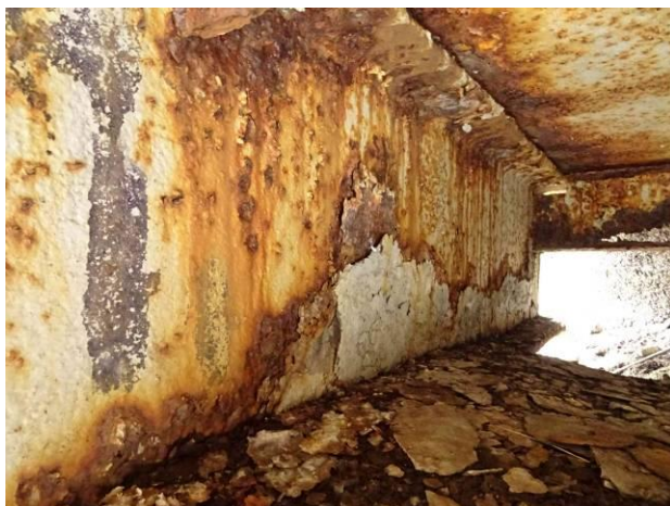
Pravý nosník nad OP1. Lístková koroze stojiny nosníku
