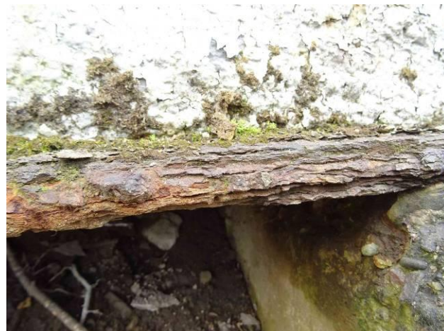
Plátková koroze spodní pásnice hlavního nosníku za OP1.
