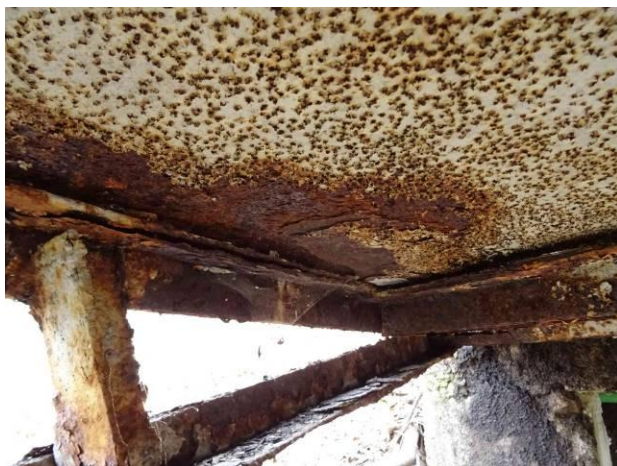
Mostovka v poli 2 NK – důlková koroze, lístková koroze úhelníků NK v poli 2.
