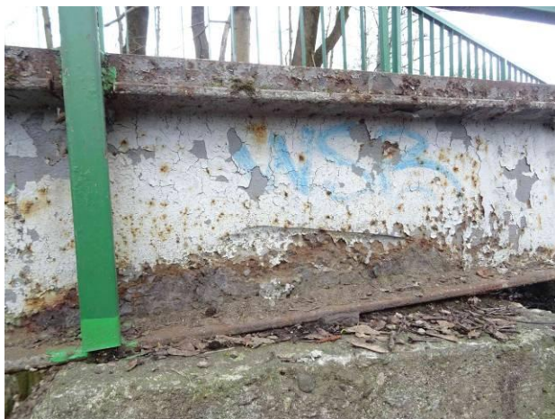
Uložení pravého nosníku na P2.
