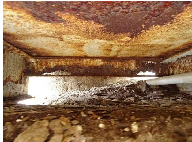
Koncový příčník nad OP1 – zcela prokorodovaná stojina příčníku.
