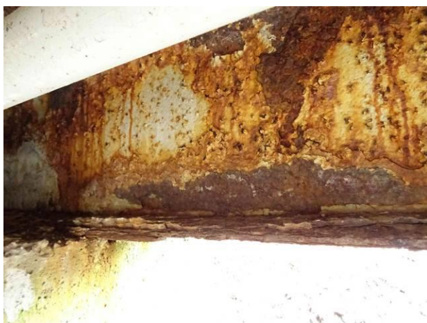
Lístková koroze spodní příruby nosníku
