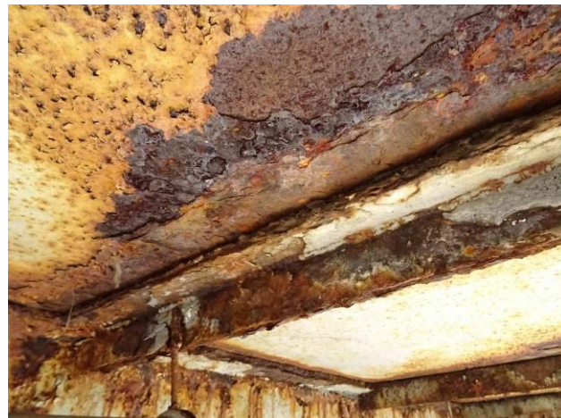
Lístková koroze mostovky a horního ztužidla
