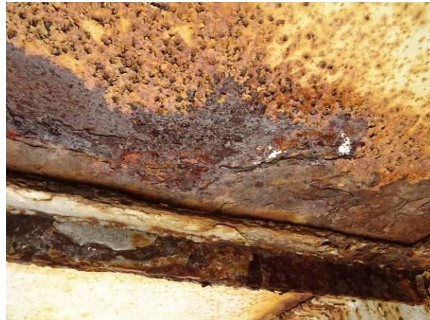
Lístková koroze mostovky a horního ztužidla
