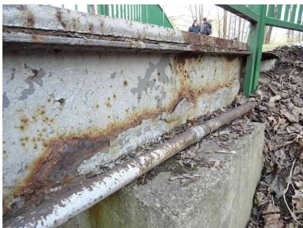
Levá strana OP1 – chybí křídlo K1L. Plátková koroze stojiny nosníku.
