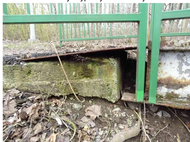
Přechodový plech před OP1. Beton vlevo je asi zhotoven na terénu.
