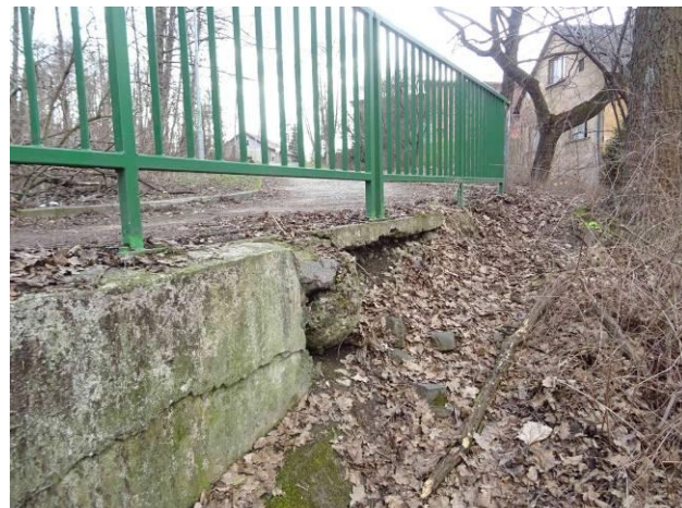
Prodloužení OP3 vpravo. Rozpad betonu nízké zídky.
