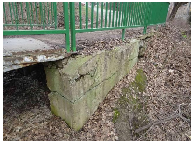
Pravá strana OP3. Vodorovná trhлина v horní části stěny.
