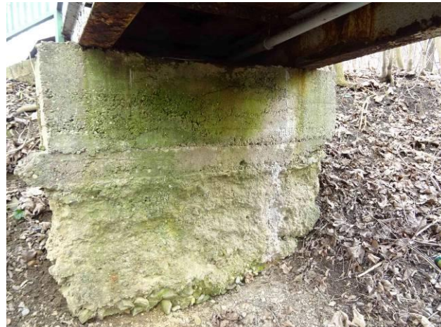
Pohled na OP1 – odplavená zemina před opěrou
