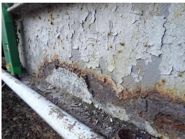
Lístková koroze stojiny nosníku.
