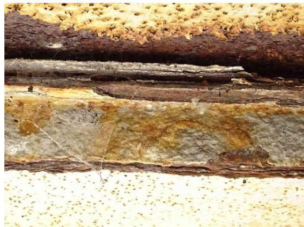
Lístková koroze úhelníku horního ztužidla
