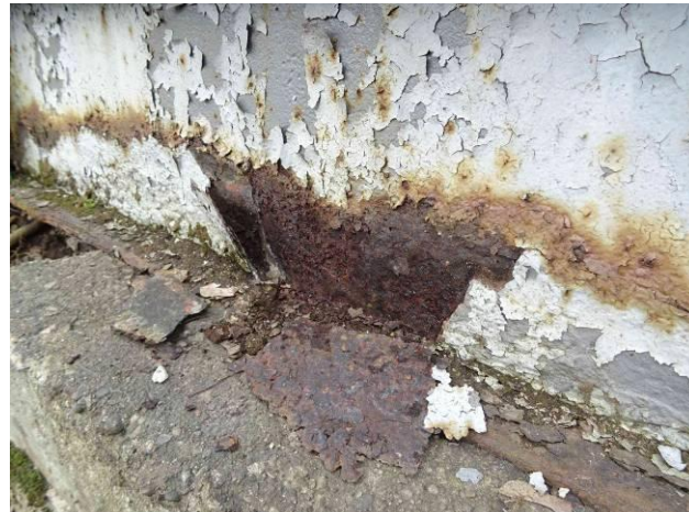
Detail foto vedle – lístková koroze stojiny nosníku.
