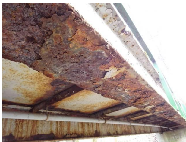
Lístková koroze spodní příruby nosníku
