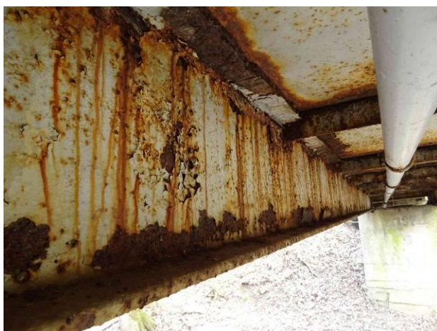
Koroze levého nosníku.
