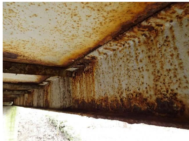
Koroze pravého nosníku.
